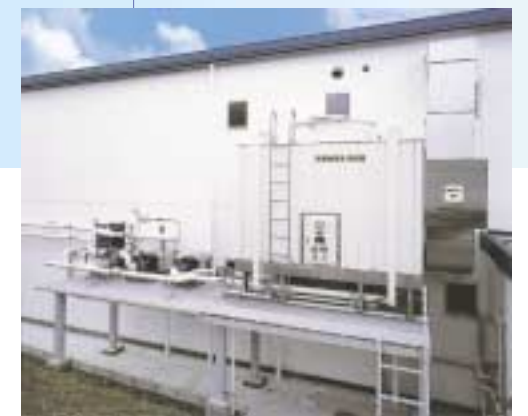
・脱臭装置&冷却塔
